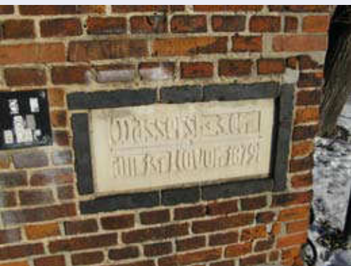
Hochwassermarken von 1879 in Wismar
